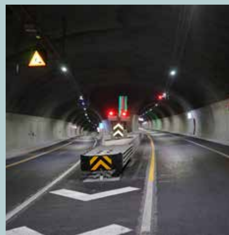
Slik ser en sikker tunnel ut. Fra Stavanger, ennå ikke åpnet. Foto: Arne Danielsen
