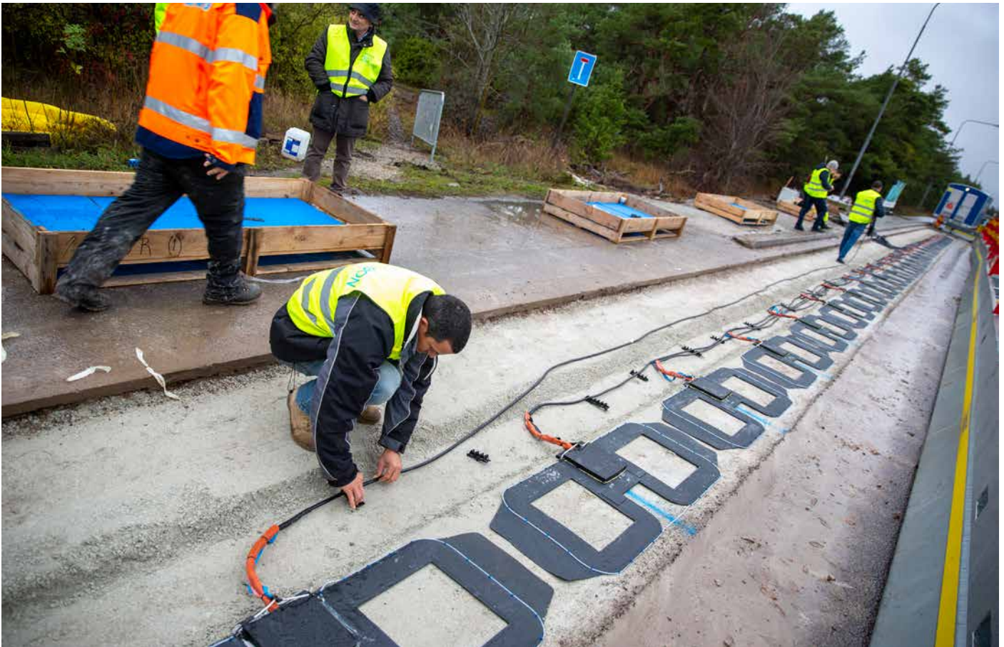
Smartroad nedlegging av kobberspolet i veibanen. Foto: Elektreon AB
